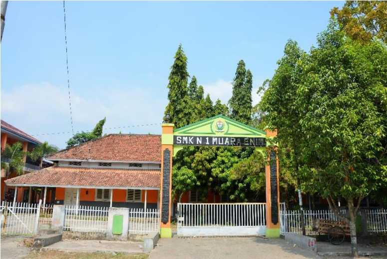
Toegangspoort linkerkant schoolgebouw, Muara Enim 2019.
